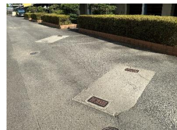
体育館前には救助袋の固定金具が設置されています。
